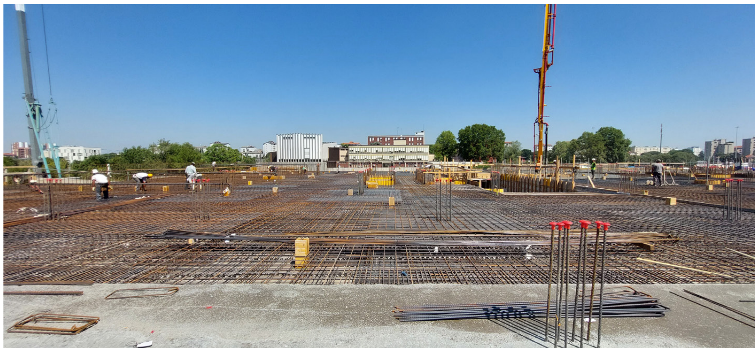
Attività di armatura e di getto calcestruzzo della copertura del piano terra (luglio 2022)
