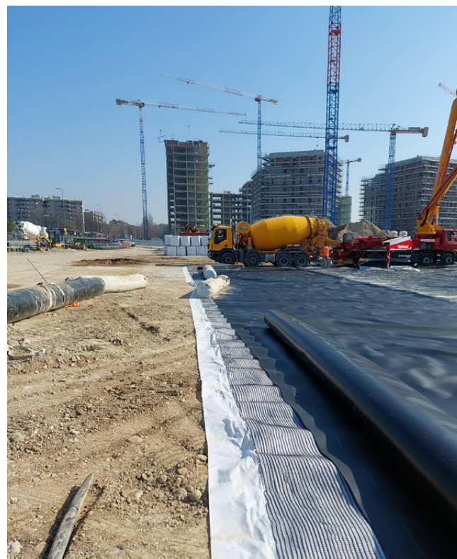
Stesura della guaina (capping) per l'ultimazione della fase di bonifica che è stata poi saldata ai manufatti in calcestruzzo dei primi due piani (marzo 2022)
