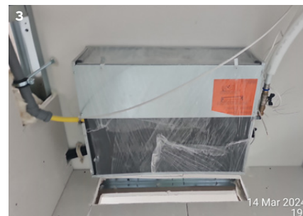
3. Protezione ventilconvettori per minimizzare accumulo di polvere e migliorare la qualità dell'aria interna durante l'uso dell'appartamento (marzo 2024) Fan coil protection to minimise dust accumulation and improve indoor air quality during use of the apartment (March 2024)
